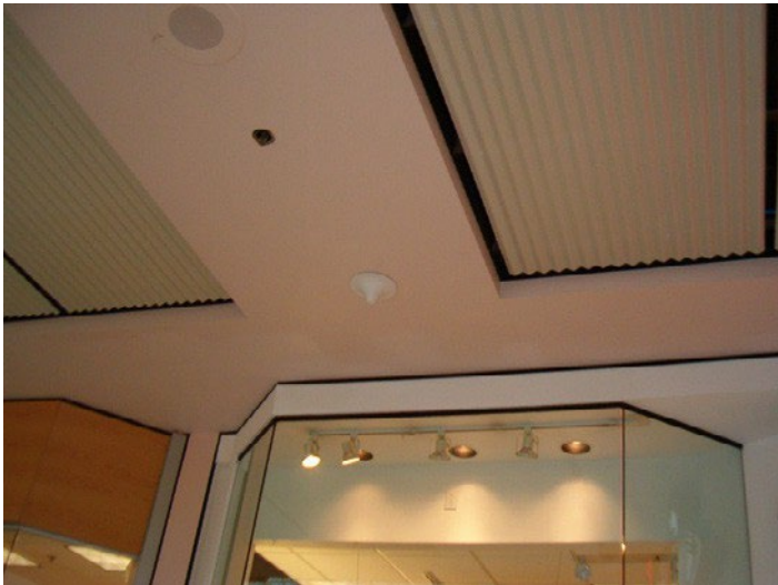
Figure 5 : Antenne omnidirectionnelle Andrew Cell-Max™ devant un magasin de détail
