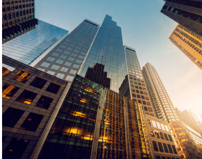
Immeuble de grande hauteur
